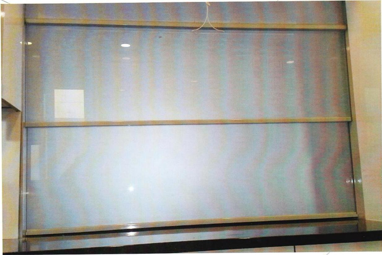
Das System kann ein fixiertes Fensterelement und ein bewegliches Fensterelement sein oder aber ein fixiertes und zwei bewegliche Fensterelemente beinhalten. Die Fensterelemente werden sich oben sammeln und der untere Bereich wird für den Durchgang frei sein.
