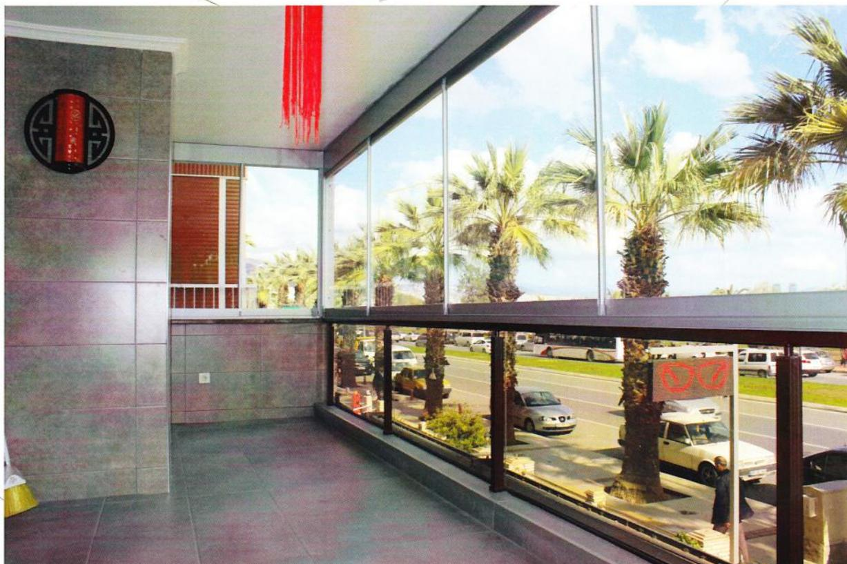
Die Fensterelemente bewegen sich horizontal und im geöffneten Zustand sammeln sie sich in beide Seiten. Die Bodenschiene hat 5 Kanäle und es sind max. 5 Fensterelemente links und max. 5 Elemente rechts sammelbar. Das System eignet sich hervorragend für Balkone, Terrassen und Geschäfte. Es gibt zwei Typen von Bodenschienen, eine mit 40 mm und eine mit 8 mm Höhe
